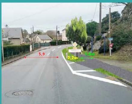
L'entrée de ville est réalisée par un rétrécissement progressif à une largeur de 5,90m. Le panneau d'entrée d'agglomération sera déplacé pour mieux la matérialiser.
