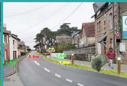
En fin de courbe, la largeur de la chaussée passera de 5,90m à 5,70m, ce qui permettra une réduction de la vitesse.
