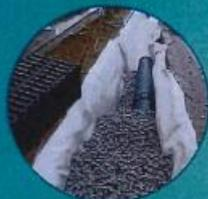
Récupération des eaux pluviales et infiltration en tranchées drainantes
